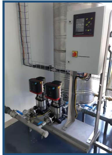
Sistema Booster Grundfos Hydro-MPC
