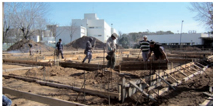
▲ Construcción de cimientos
