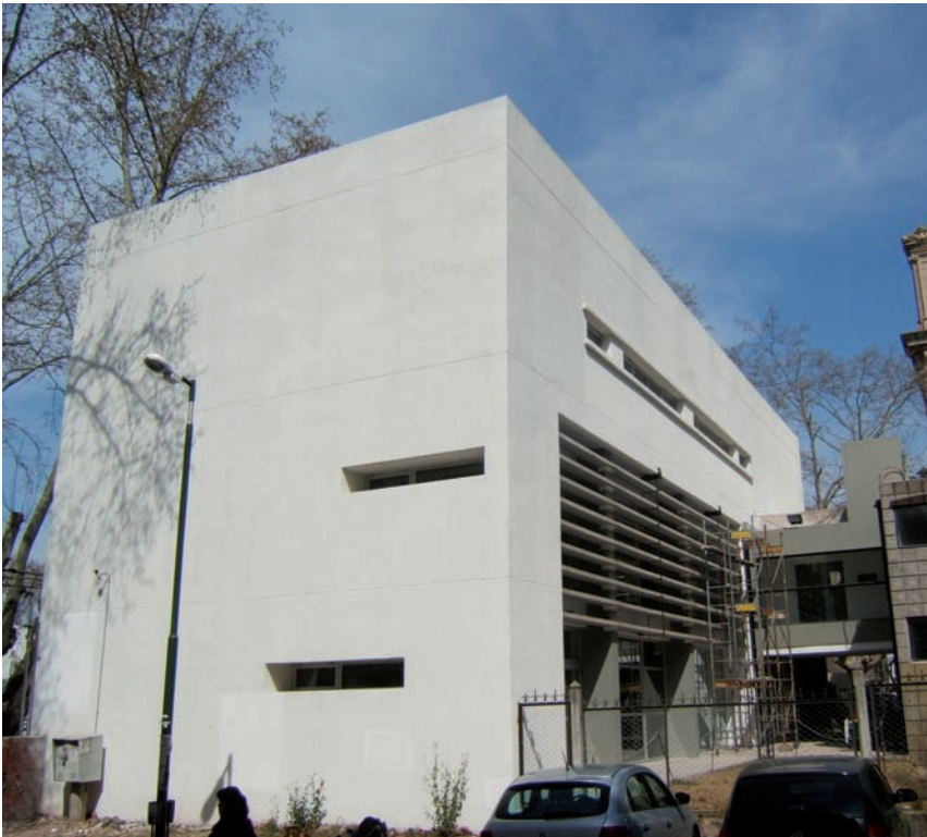
▲ Vista fachada posterior
