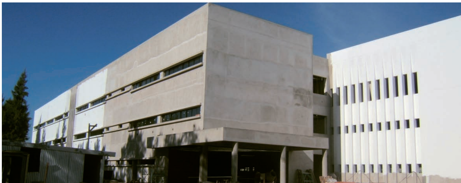
▼ Edificio en obra
