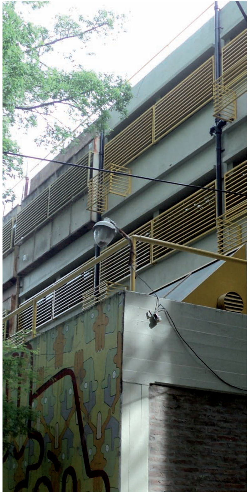
▲ Vista de exterior
