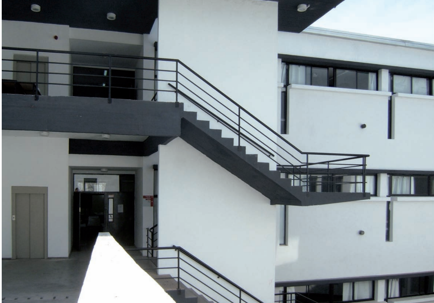
Exterior desde puente ▲
