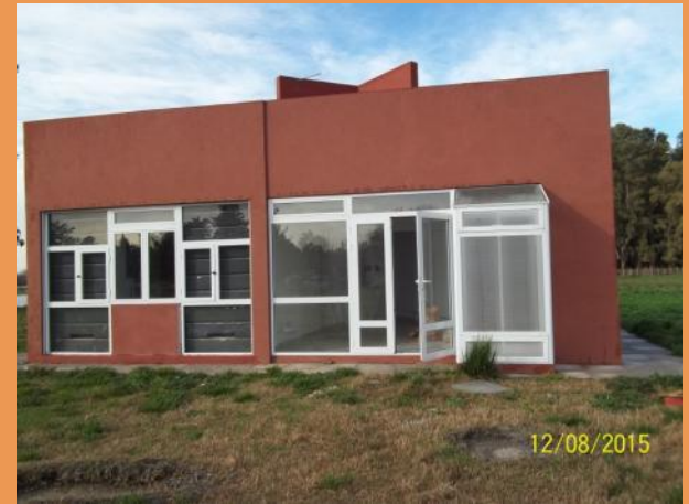
MACs instalados en una V.I.S.
