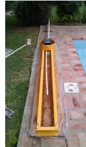
Proceso de construcción del Pilar de luz, premoldeado de hormigón, alternativo.
