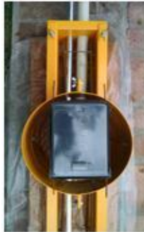
Proceso de construcción del Pilar de luz, premoldeado de hormigón, alternativo.
