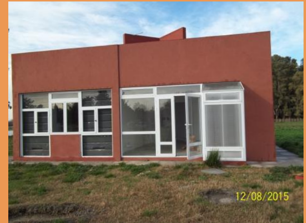
MACs instalados en una V.I.S.
