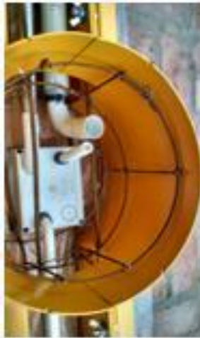
Proceso de construcción del Pilar de luz, premoldeado de hormigón, alternativo.
