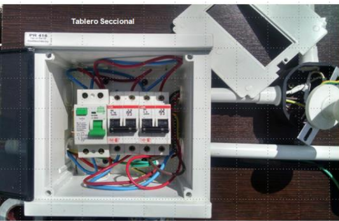
Modelo de tablero e instalación domiciliar
