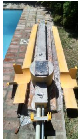
Proceso de construcción del Pilar de luz, premoldeado de hormigón, alternativo.
