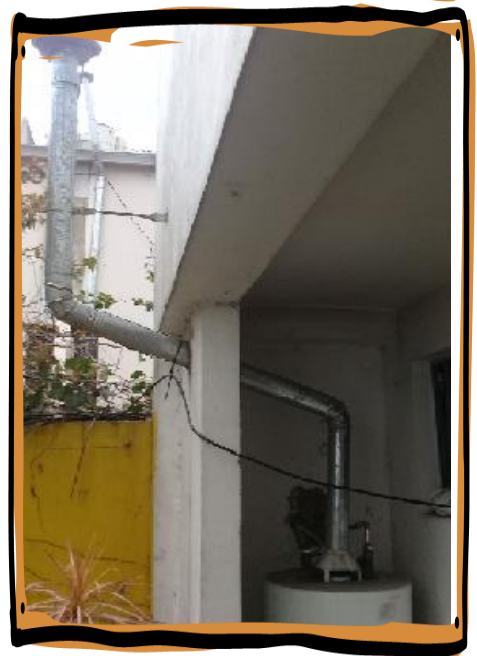
Salida de ventilación con desvío a 45° reglamentario
