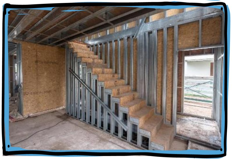
Escalera de vivienda en Perfilera C recubierta de aglomerado
