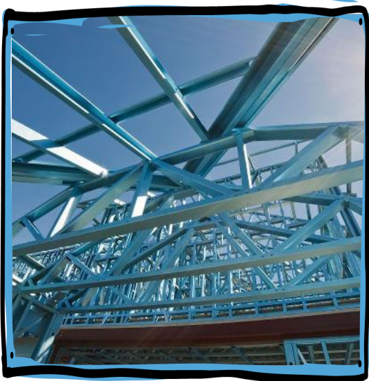
Estructuras en Perfilera C, sistema Steel Framing
