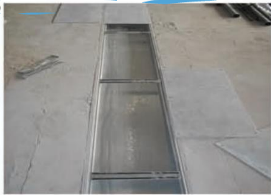
i| Vista de los perfiles soporte de tapa OQA/DT350Q. La provisión de cada tramo de canal de 2,40 mts de largo incluye la provisión de 6 u. de estos perfiles.
