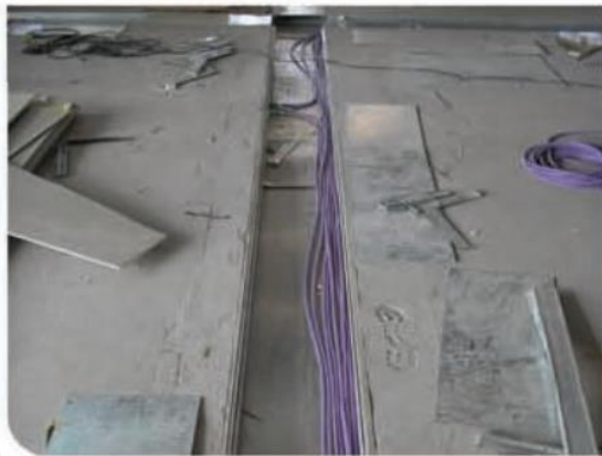
K| Montaje de tapa y cableado en canal a ras del pavimento.
